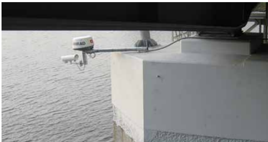
■ Instalacja radaru na moście – autostrada wschód Źródło: Urząd Żeglugi Śródlądowej w Szczecinie.
